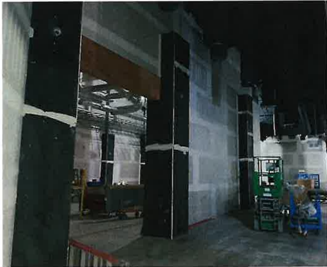
Remodel Drywall Taping
