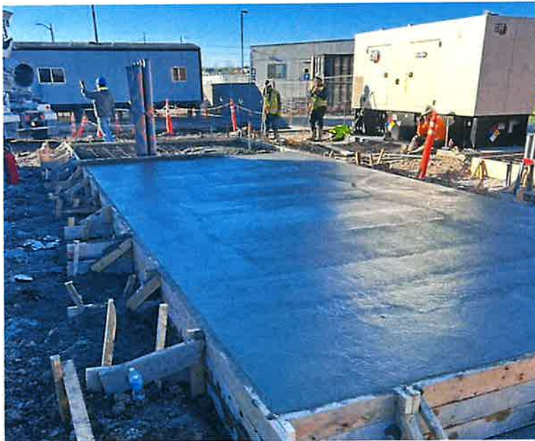
Pouring the Generator Pad
